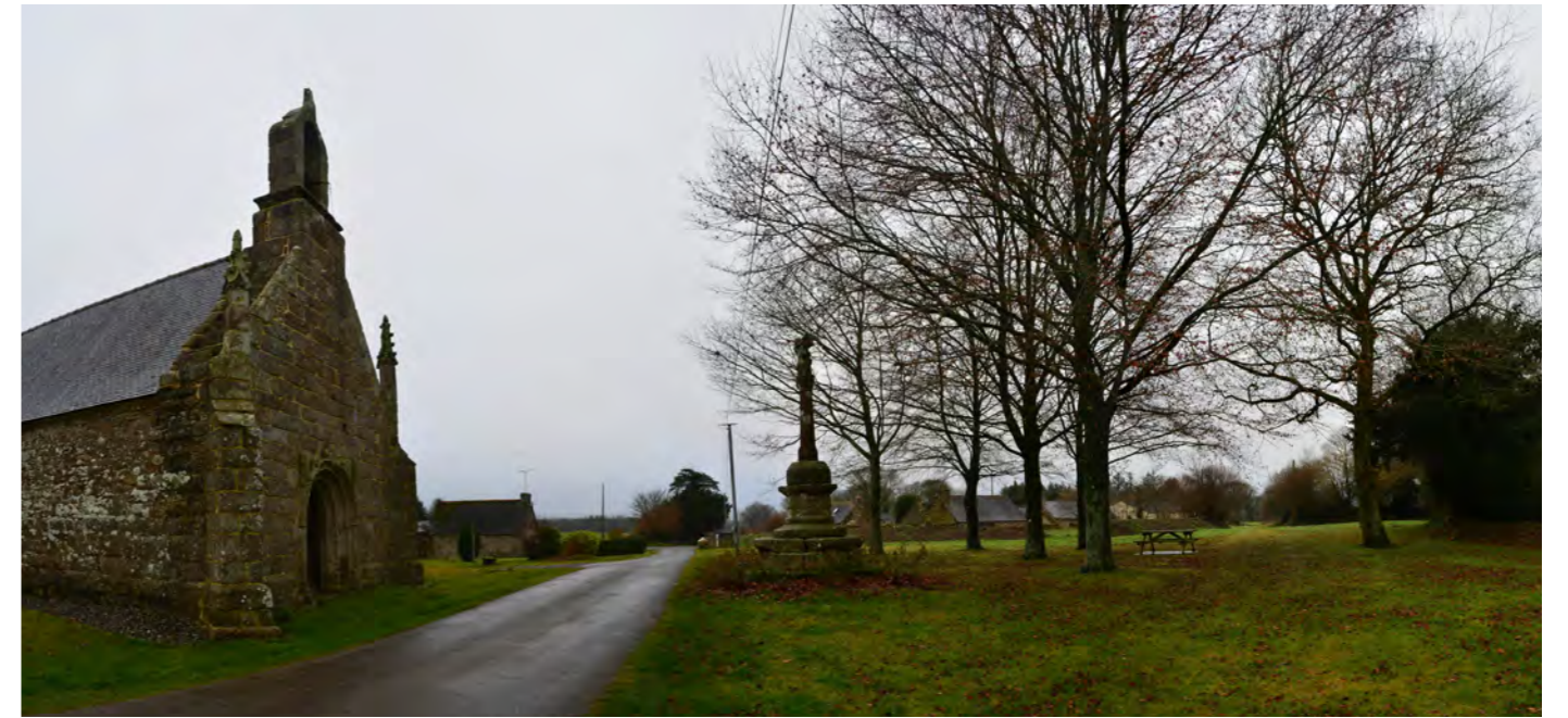
Photo 61 : Vue en direction du projet depuis les abords de la chapelle Saint-Colomban
