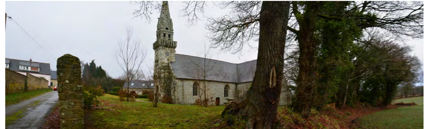
Photo 64 : Transition perméable entre l'église est les parcelles au sud
